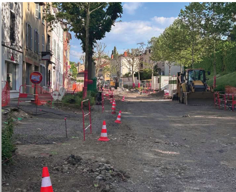
La première phase du chantier a consisté en la rénovation complète des réseaux souterrains
