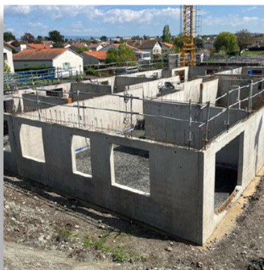
Les grues se sont installées sur le chantier en avril
