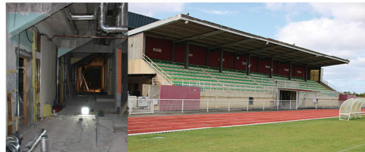
RENOUVEAU - Les vestiaires du municipal passeront bientôt de l'ombre (vétustes) à la lumière (modernes). Un aménagement supplémentaire pour un stade du Docteur Jalenques fonctionnel et régulièrement amélioré.
