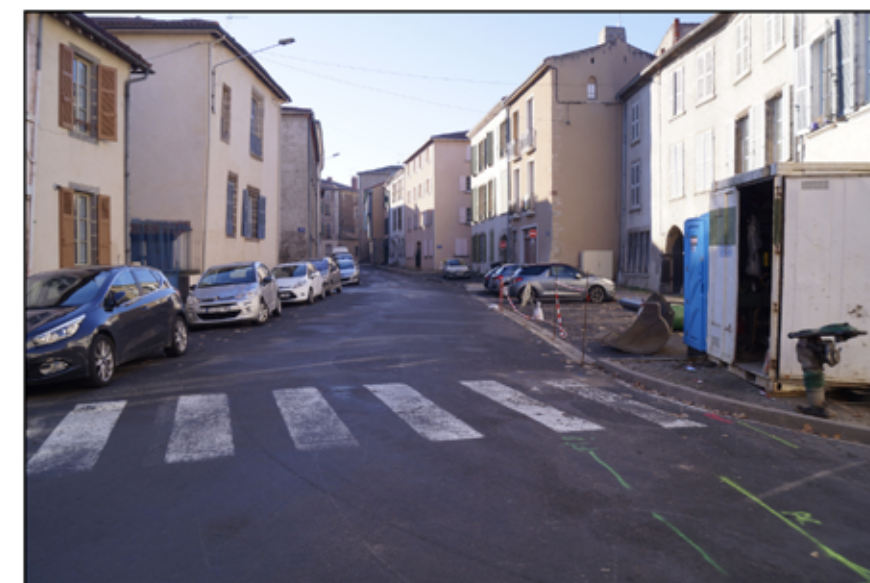
RENOVATION – En juin prochain, au terme de 7 mois de chantier, la rue Pascal et la place du Pointel et leurs réseaux auront fait peau neuve. Une étape supplémentaire dans la réhabilitation d'ensemble du centre-ville et de sa périphérie immédiate.
