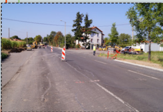
Après les travaux sur la RD 912 entre Vieille-Brioude et Brioude vient de débuter l'aménagement du chemin de Lachaud qui desservira le Centre Aqualudique Intercommunal ainsi que le camping.
