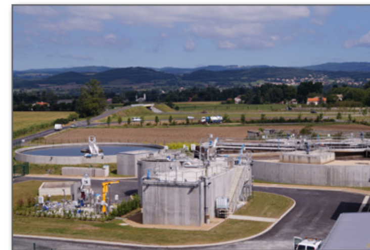
La nouvelle station d'épuration affiche d'excellents résultats de dépollution des eaux usées et garantit ainsi la qualité de notre ressource en eau.
